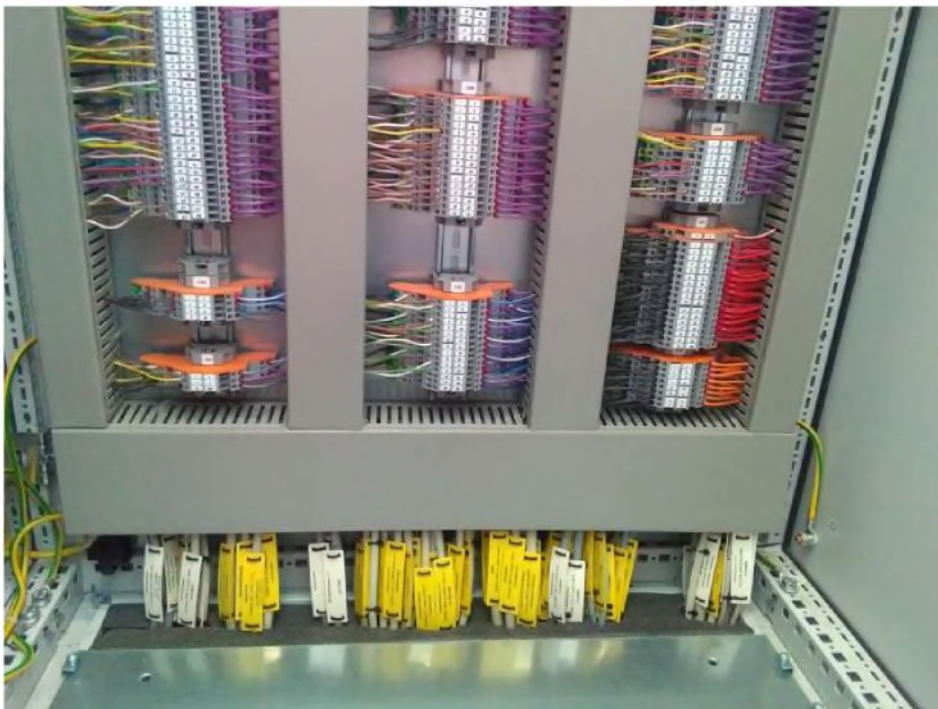
Schaltschrank Kabeleinführung
