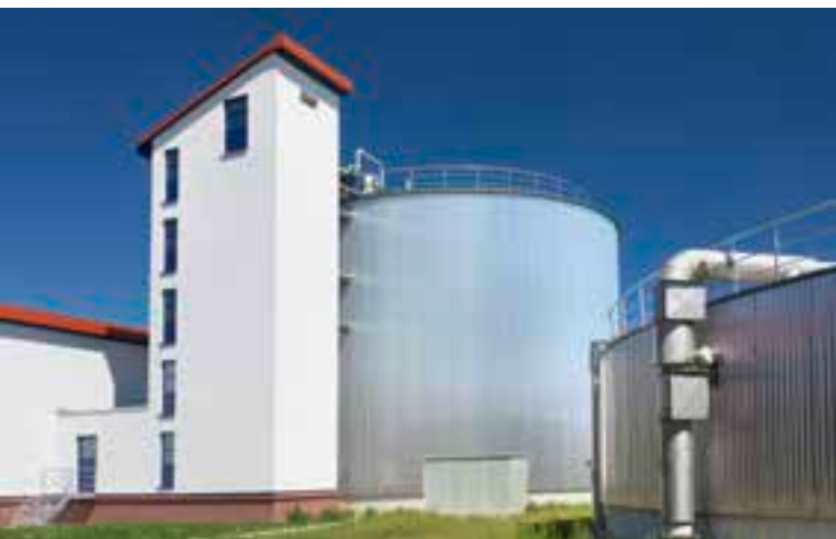
Der Entwässerungsbetrieb investiert in einen zusätzlichen Faulturm.
