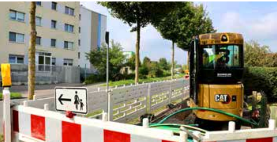
Während der Bauphase ist die Verlegung eines Glasfaser-Hausanschlusses für die Immobilien-eigentümer kostenfrei – auch die Hausinstallation für Wohnungen ist ohne Zusatzkosten möglich!
