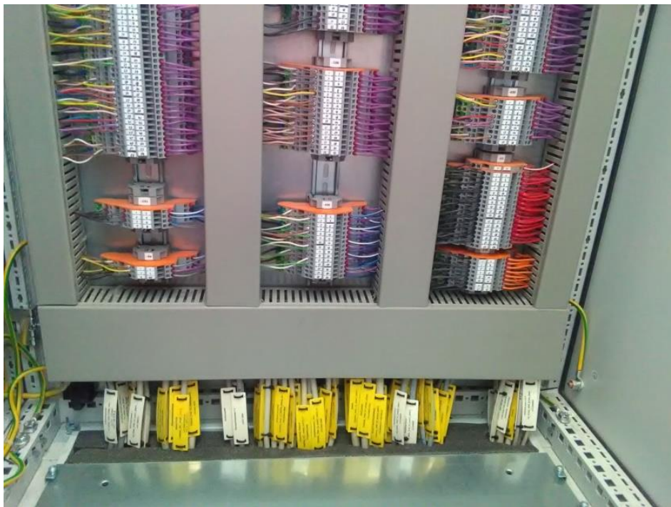
Schaltschrank Kabeleinführung
