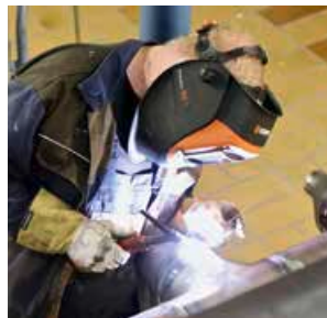
Monteur bei Arbeiten in der Maschinenhalle des Blockheizkraftwerkes
