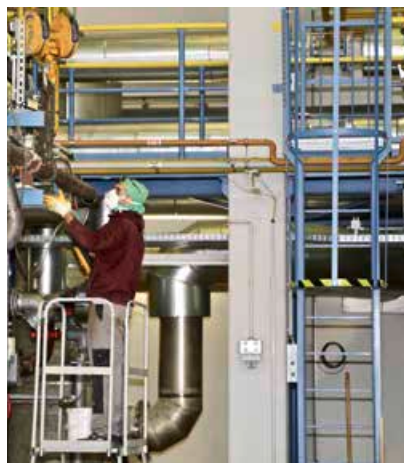
Vor dem Abtransport wurden die Module in der Halle des BHKW Berliner Straße demontiert. (kleines Bild)
