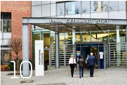
Das Krankenhaus Paul Gerhardt Stift gehört zu den Fernwärme-Kunden der ersten Stunde.
