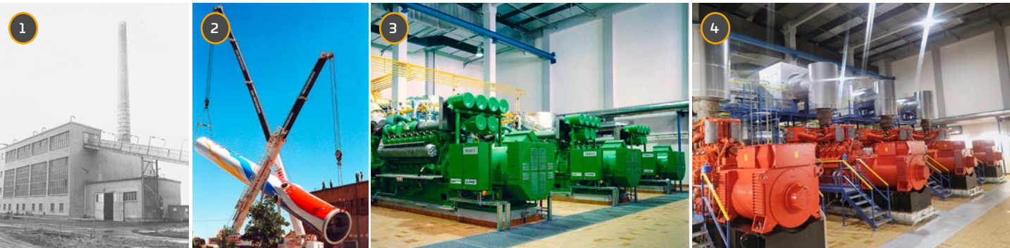
(1) Das alte Kesselhaus 1980; (2) Der Schornstein an der Berliner Straße wird aufgestellt (1994); (3) 1995 Inbetriebnahme der vier BHKW-Motoren; (4) 2018 Austausch der Motoren mit noch effizienteren Modulen
