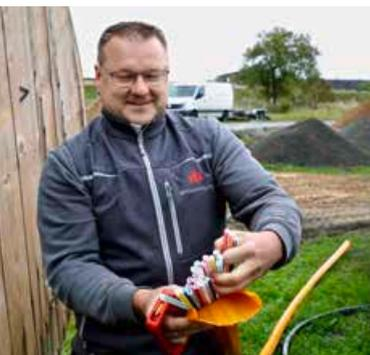
Andreas Beck von der wittenberg-net bei den Verlegungsarbeiten. In die farbigen Leerrohre werden die Glasfasern eingeblasen.
