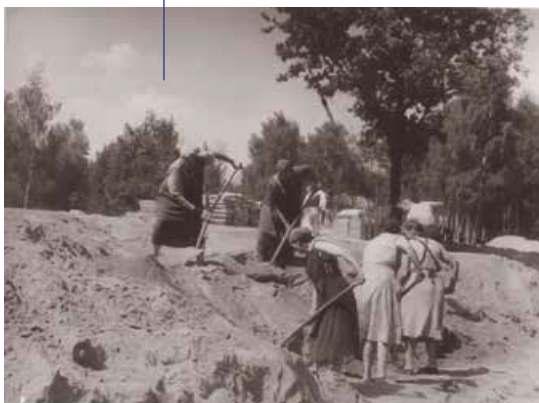
Die Becken wurden per Hand ausgeschachtet. Schippe, Schubkarre, Förderband und Betonmischer waren die wichtigsten Hilfsmittel. 10.000 Kubikmeter Erddreich mussten bewegt werden.
