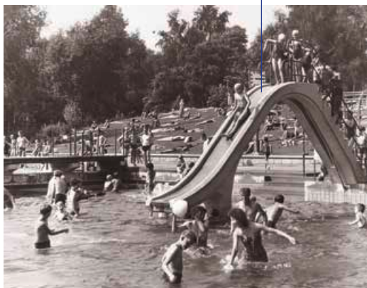
Hinter der Rutsche, einer Spezialanfertigung aus Beton, entstand die aus dem Beckenaushub aufgeschüttete Liegewiese.
