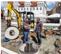
Während der Bauarbeiten
